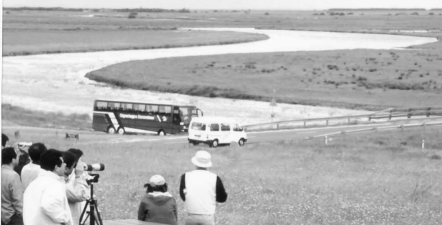
デンマーク・「デンマークスキャン川の再生復元」生物多様性と地下水汚染対策のために直線化した河川を蛇行した河川に戻し湿地を再生
