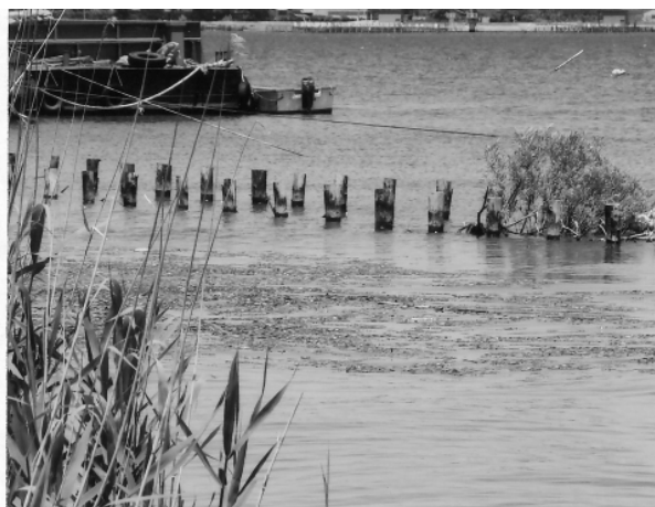
霞ヶ浦・「水質浄化のために湖岸を再生」粗朶を組み、アサザを植栽しヨシ原を復元し水質を改善しようとしている。
